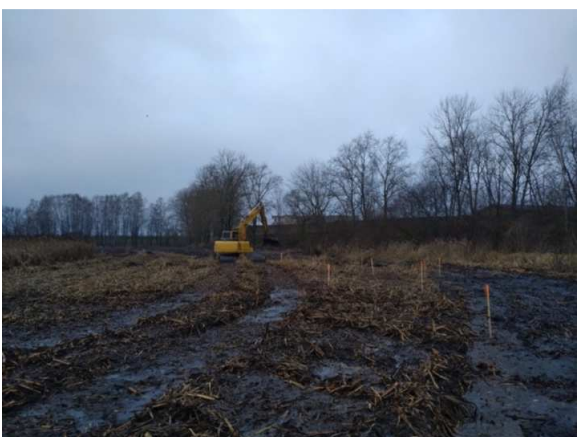
19. un 20. attēli. Atbilstoši dabā nospraustajām robežām veikta ūdensaugu, dūņu un grunts materiāla izrakšana un izlīdzināšana (Foto: U. Valainis)
