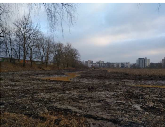
19. un 20. attēli. Atbilstoši dabā nospraustajām robežām veikta ūdensaugu, dūņu un grunts materiāla izrakšana un izlīdzināšana (Foto: U. Valainis)
